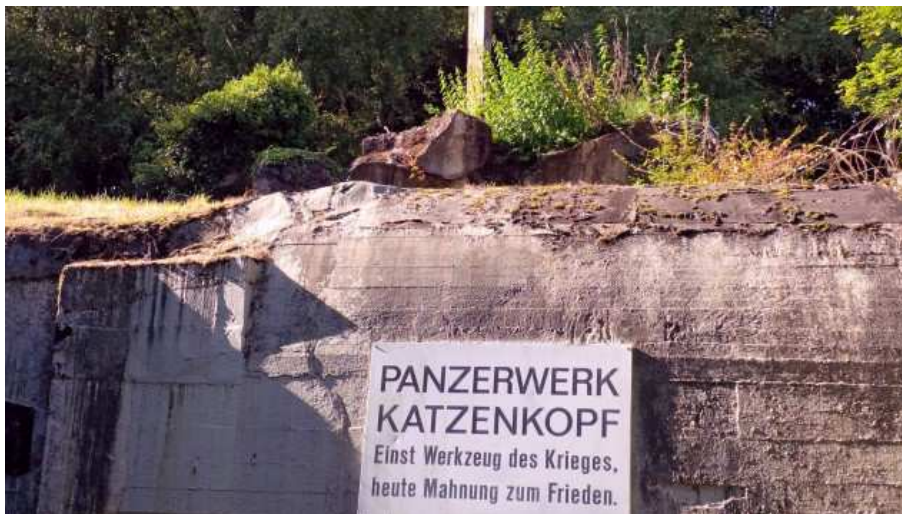
Ein gesprengte Bunker am Westwal, in dem sich das Panzerwerk "Katzenkopf" befand. (Deutschlandradio / Anke Petermann)
